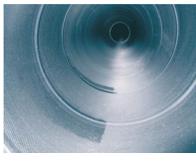
Üleval väljavõtte tabelist Visuaalse hindamise näidis torustikust tolmu tase 0,4\text{ g/m}^2 kohta (normide kohane)
